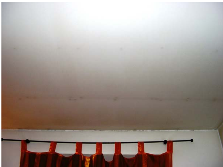
Fig. 6- Altro particolare del controsoffitto.
